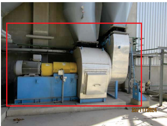
รูปที่ 18 พัดลมดูดอากาศ (Primary Air Fan) จากบ่อรับกากอุตสาหกรรม และภายในอาคารรับกากอุตสาหกรรม
