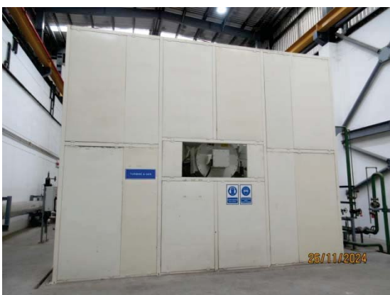
รูปที่ 21 Insulation บริเวณที่มีเสียงดัง
