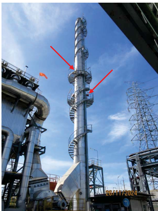
รูปที่ 11 จุดตรวจวัดมลพิษก่อนระบายออกของปล่อง Boiler (CEMs)
