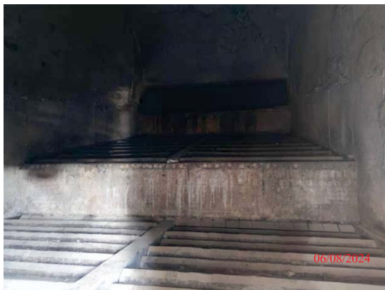
รูปที่ 5 เตาเผาแบบตะกรับ (Stoker Grate Firing)
