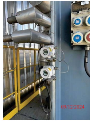
รูปที่ 78 อุปกรณ์ตรวจวัดอุณหภูมิของหม้อไอน้ำ
